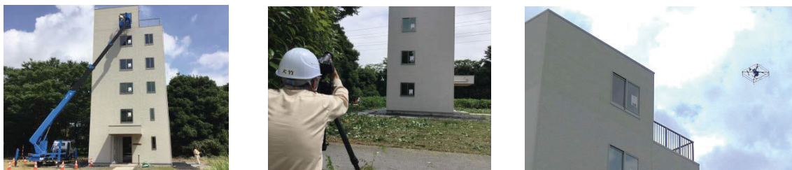
①高所作業（目視点検）
