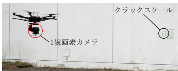
図7 ドローンによる撮影状況
